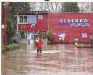
Das Elbebad ist „geschlossen“. Für den Rest des Winters wird das Elbebad-Team alle Hände voll zu tun haben, da bei der Eis-Entsorgung Schäden immer zu beheben, weiter eine Wartung.
